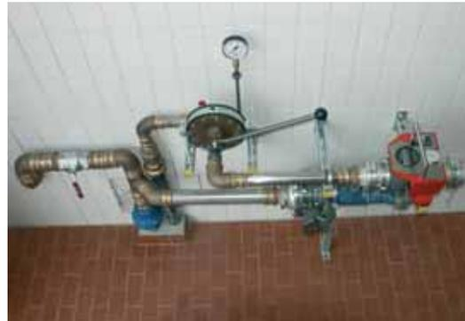
Außerdem ist in der Waschhalle ein Pumpenprüfstand eingebaut, mit dem die Feuerlöschkreislumpen regelmäßig auf ihre Leistungsfähigkeit überprüft werden können. Der Prüfstand wird auch im Rahmen der Maschinenausbildung eingesetzt.
